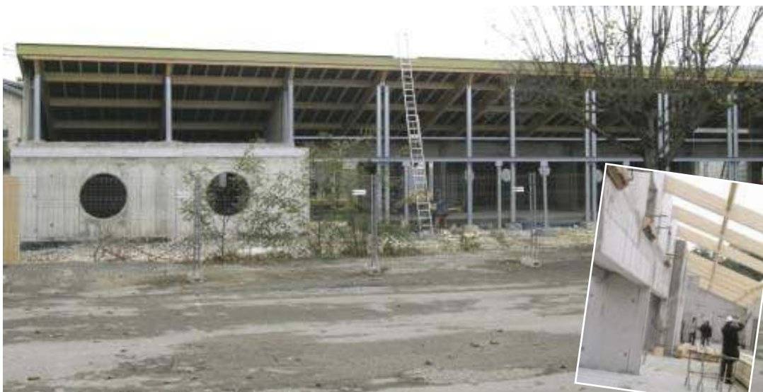
Le chantier de l'école maternelle du Quai.
